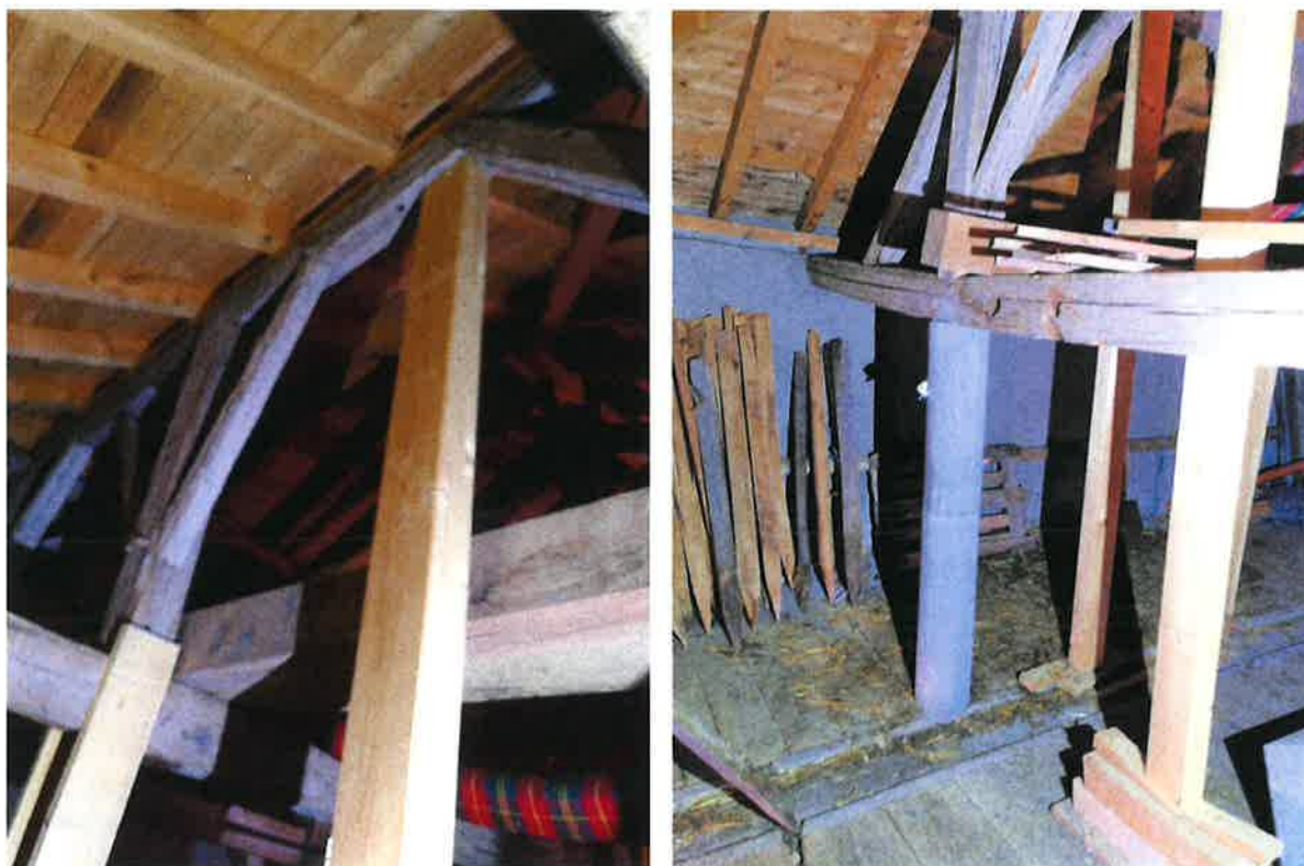
Photos 2 & 3 – Etayage de l'étable et de la zone de vie
